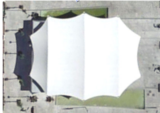
Bordes flexibles de la cubierta del acuario de Almuñécar. Están reforzados por un cable alojado en el interior de la relinga perimetral.
