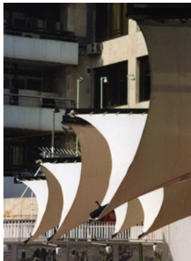
La membrana carece de refuerzo.
